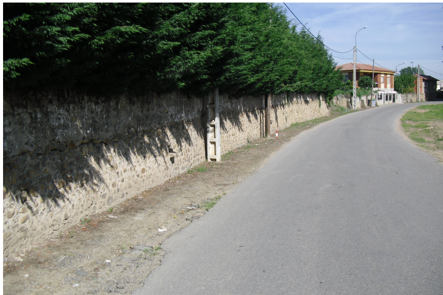
Muro que delimita el sector sobre el camino del cementerio
