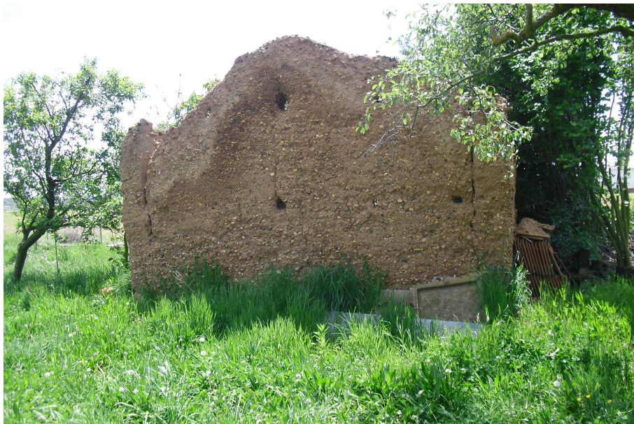
Caseta de finca de tapial dentro del sector
